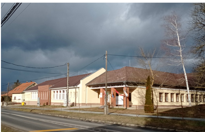
az általános iskola épülete
