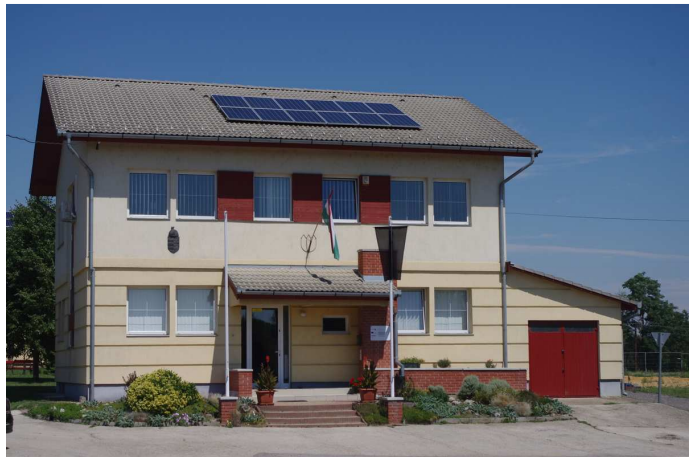
a hivatal épülete – utcafronti homlokzat
